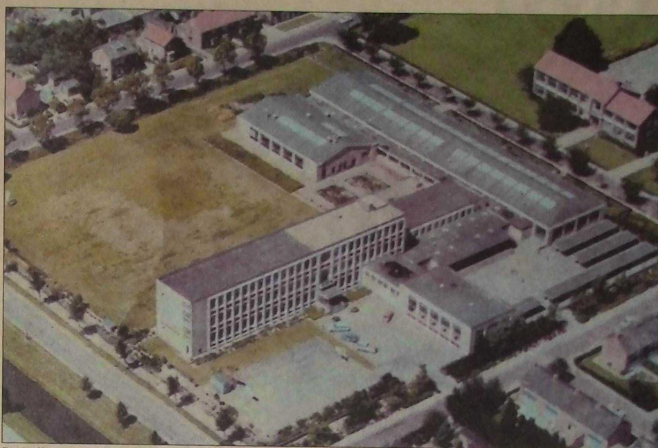
De Willemslaan anno 1970. Let op de contouren van het oude gebouw in het grasveld.
